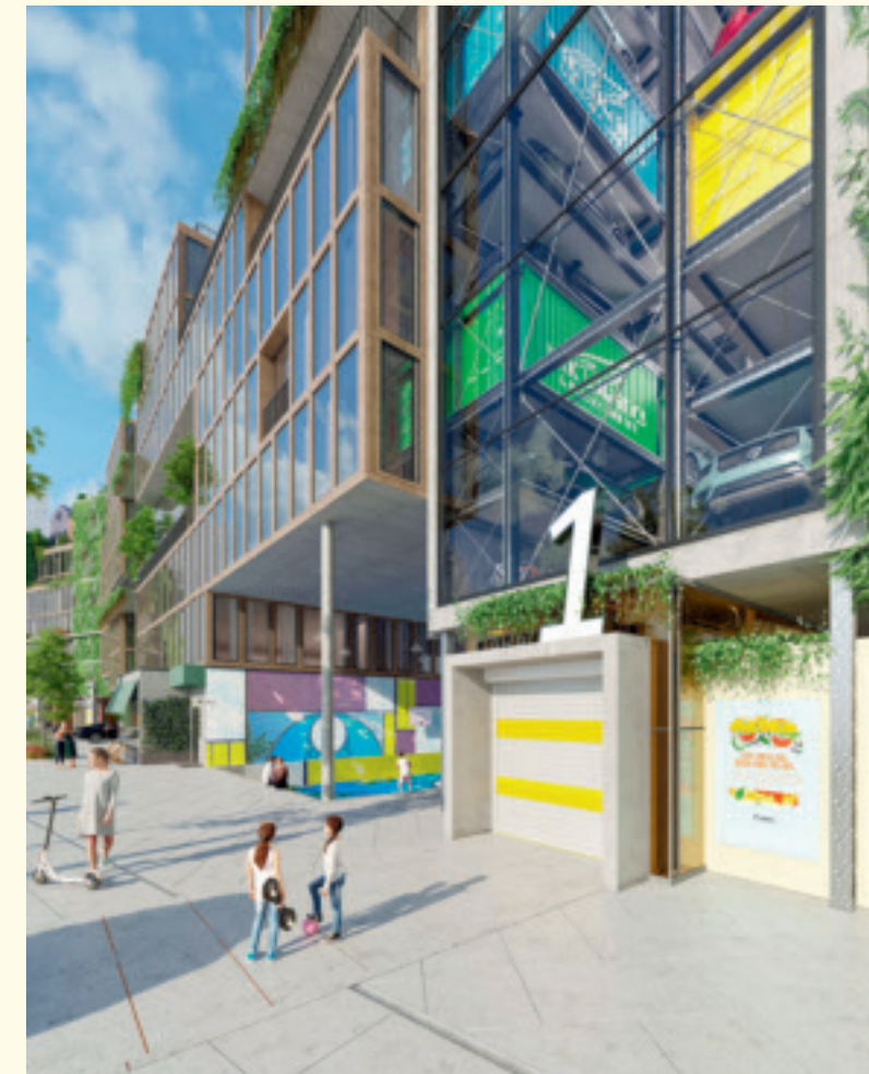
Rechts: ein Wöhr Parksafe 583 – der auf neun Ebenen über 135 m² Grundfläche 52 Stellplätze bietet –, wie er am Kneuterdijk in Den Haag neben einem alten Bankhaus eingebaut wurde. Foto: Esspe Studios
