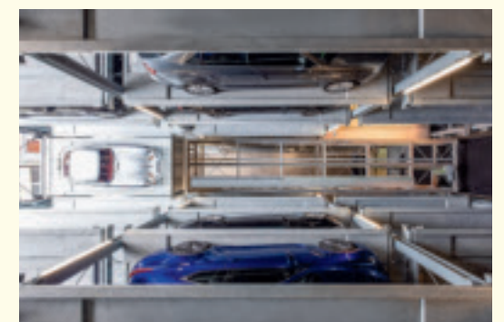
Rechts: ein Wöhr Parksafe 583 – der auf neun Ebenen über 135 m² Grundfläche 52 Stellplätze bietet –, wie er am Kneuterdijk in Den Haag neben einem alten Bankhaus eingebaut wurde. Foto: Esspe Studios
