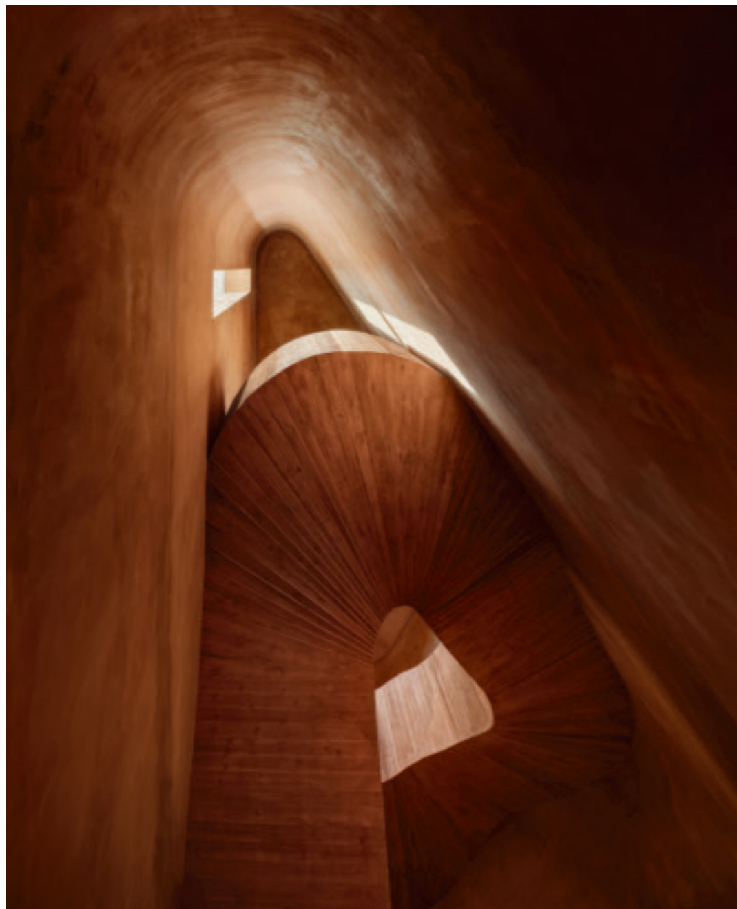
Treppe als Erlebnisraum: Im Prisma befindet sich ein Pendant zum Bestand. Der ebenfalls mit Ziegelstaub rot gefärbte Sichtbeton wurde gebogen statt polygonal geformt.
