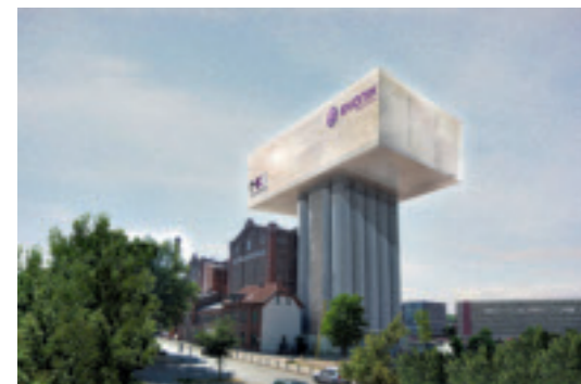
Der erste Erweiterungsentwurf von 2008 sah einen transluzenten Container vor, der auf die Silos gesetzt werden sollte. Ein Baustellenbrand sowie festgestellte gravierende Ausführungsmängel an den Schweißnähten sorgten für den Baustopp und der Entsorgung der unfertigen Stahlkonstruktion. Visualisierung: Herzog & de Meuron
