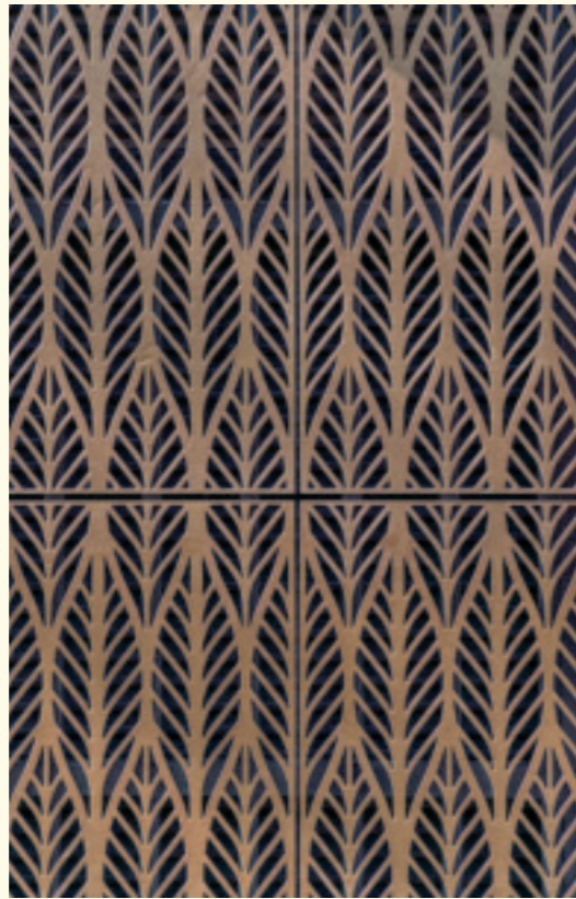
Gegossen oder gefräst, das Blattmuster auf den Platten der Vorhangfassade am Turm wie auch die Gitter am Sockel spielen auf den nahen Regent's Park an. Grundriss im Maßstab 1:500
