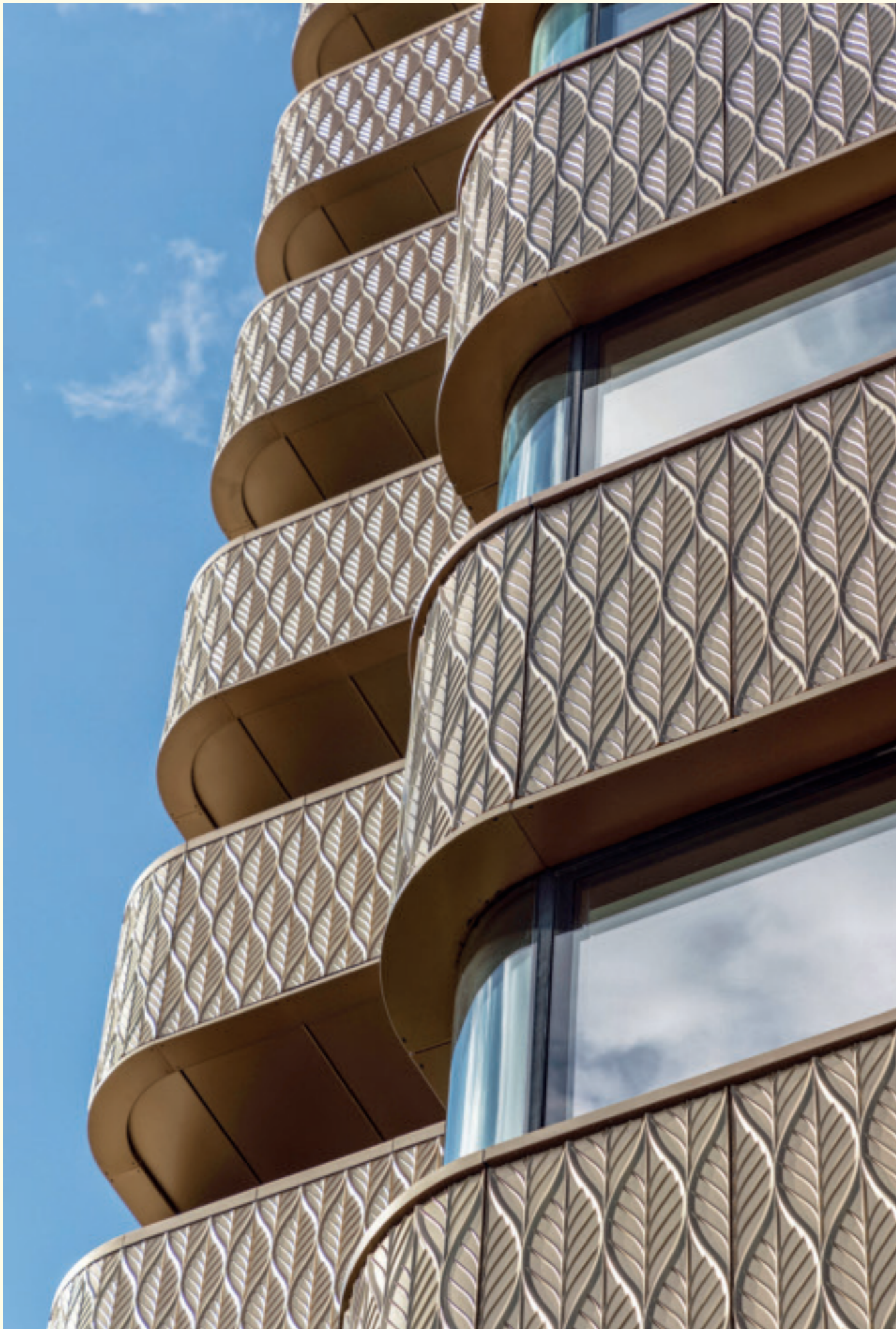
Die beschichtete Aluminiumfassade changiert von bronzen über silbern bis golden. Die Profilierung lässt je nach Lichteinfall Blattadern hervortreten. Gebäudefotos: by courtesy of Regal London
