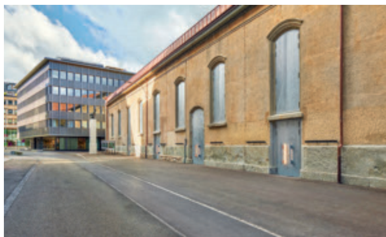
Die Reithalle ist Teil des Kasernenareals von Aargau, das umgenutzt wird. Die Mauern sind fast unverändert geblieben. Das Dach erfuhr eine Aufdopplung mit Kupferblech. Foto oben: Jiri Makovec
