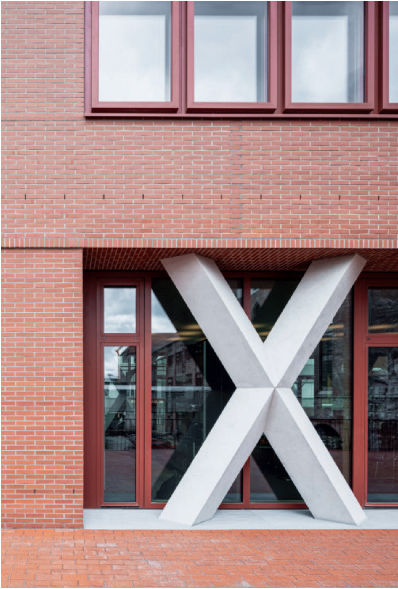
Kein Dekor, auch wenn es einen Betonkosmetiker brauchte, um die Xe in dieser Qualität zu realisieren: Die Stützen sind Teil eines Vierendeelträgers und nehmen die Last der Hochhausseife auf. Lageplan im Maßstab 1:10.000
