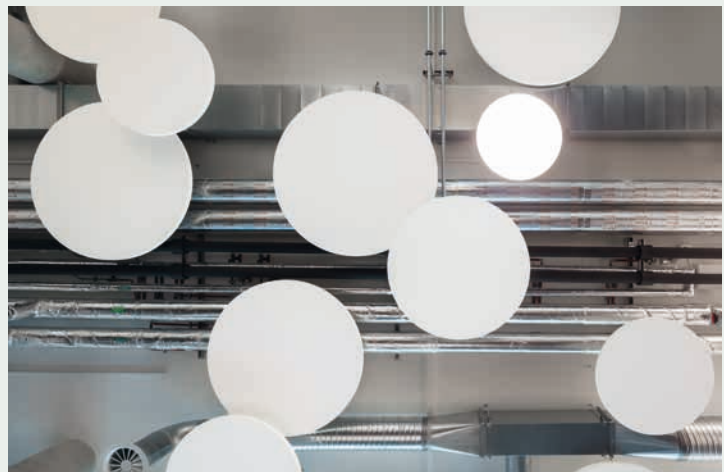
Die Anordnung der Akustikelemente und der Technik lässt die Leitungen, Traversen und Rohdecken sichtbar. Foto: HGEsch Photography für Ecophon
