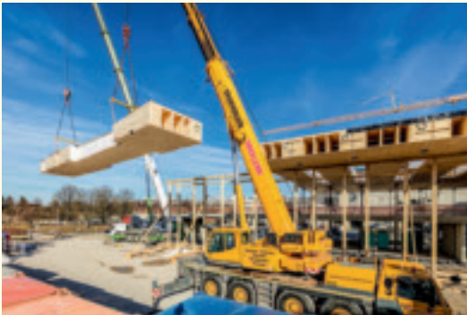
Montage der 19 Tonnen schweren Vordachelemente mit dem Autokran. Foto: Markus Buck
