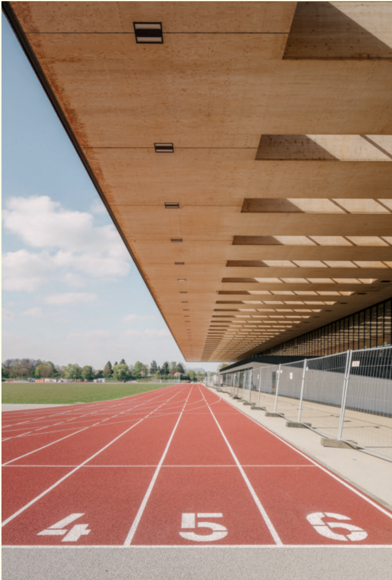
Das annähernd 19 Meter auskragende Vordach auf der 153 Meter breiten Westseite des Campus besteht aus insgesamt 40 Hohlkastenelementen aus Fichtenholz, die 9,30 Meter tief ins Gebäude rückverankert sind. Fotos: Aldo Amoretti
