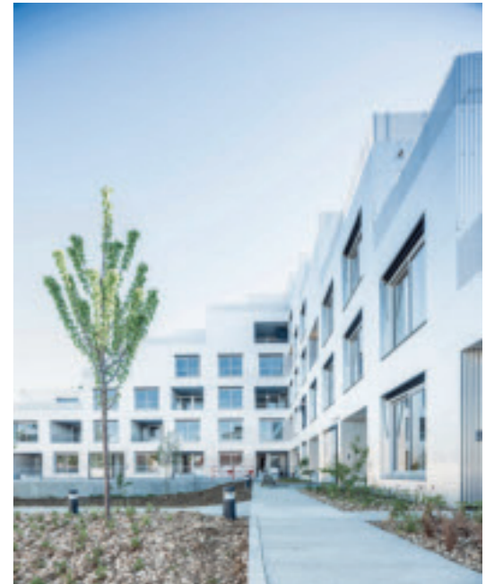
Der Wohnbau Unité(s) von Sophie Delhay bietet in seiner strengen Geometrie eine flexible Nutzung (Bauwelt 17.2020). Foto: Bertrand Verney
