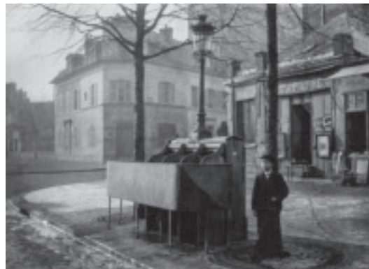
Das gusseiserne „Pissoir mit drei Ständen“, an einer Pariser Straßenecke, 1865. Vor allem unter dem Stadtumbau durch Baron Haussmann wurden vermehrt öffentliche Urinale eingeführt. Foto: Charles Marville
