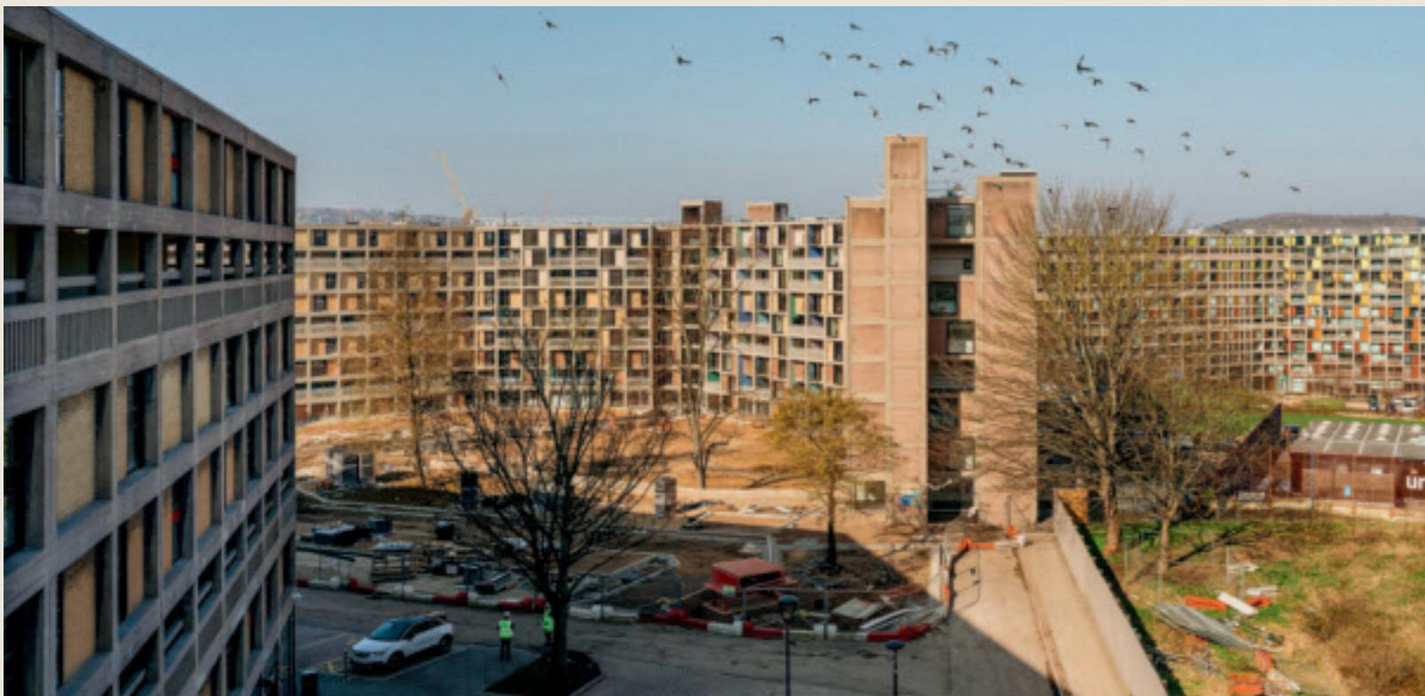
Da Sichtbetonstruktur und Bestandsmauerwerk erhalten werden müssen, wurde versucht, über Innendämmung und die farbigen, gedämmten Putzwandelemente so viele Wärmebrücken zu vermeiden wie möglich.
