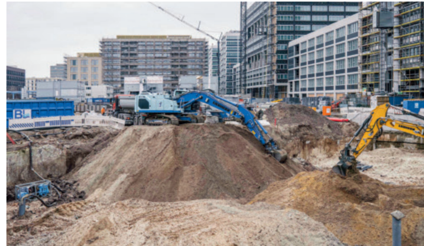
Kann weg? Tonhaltiger Aushub auf einer Baustelle in Berlin-Mitte. Foto: Alexander Jerosch-Herold, Jakob Krauss
