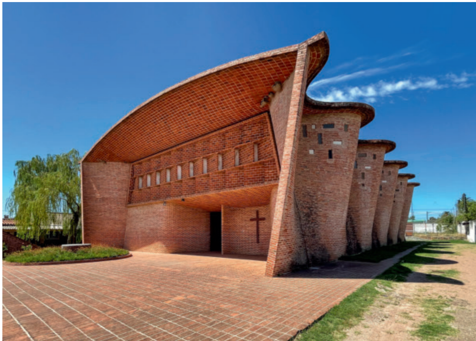
Cristo Obrero Die Kirche in Atlántida realisierte Eladio Dieste 1960. Foto: Matthias Beckh
