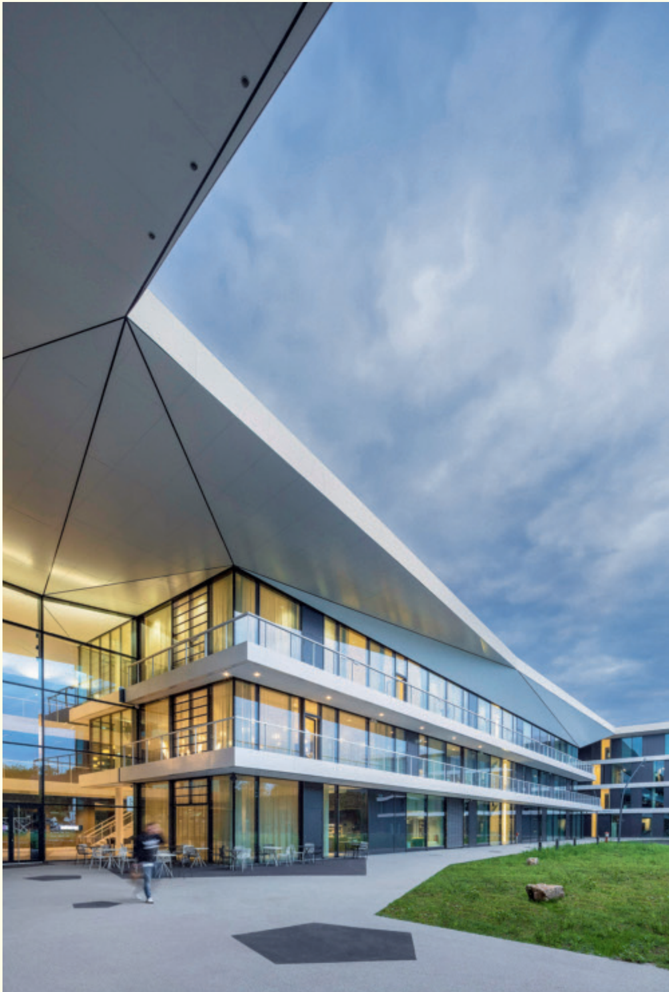
Der zentrale Gebäudeeingang zur Schwarzwaldstraße. Im rechts davon anschließenden Riegel befinden sich Restaurant sowie Konferenzräume.
