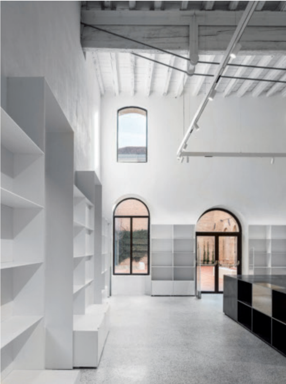
Für den Bookshop wurde die historische Höhe des Saals durch das Entfernen einer Zwischendecke zurückgewonnen, das Holztragwerk der Decke wurde mit Stahl verstärkt. Das kleine Foto rechts unten zeigt die Caffè-Bar. Schnitt Rossetti-Flügel im Maßstab 1:500
