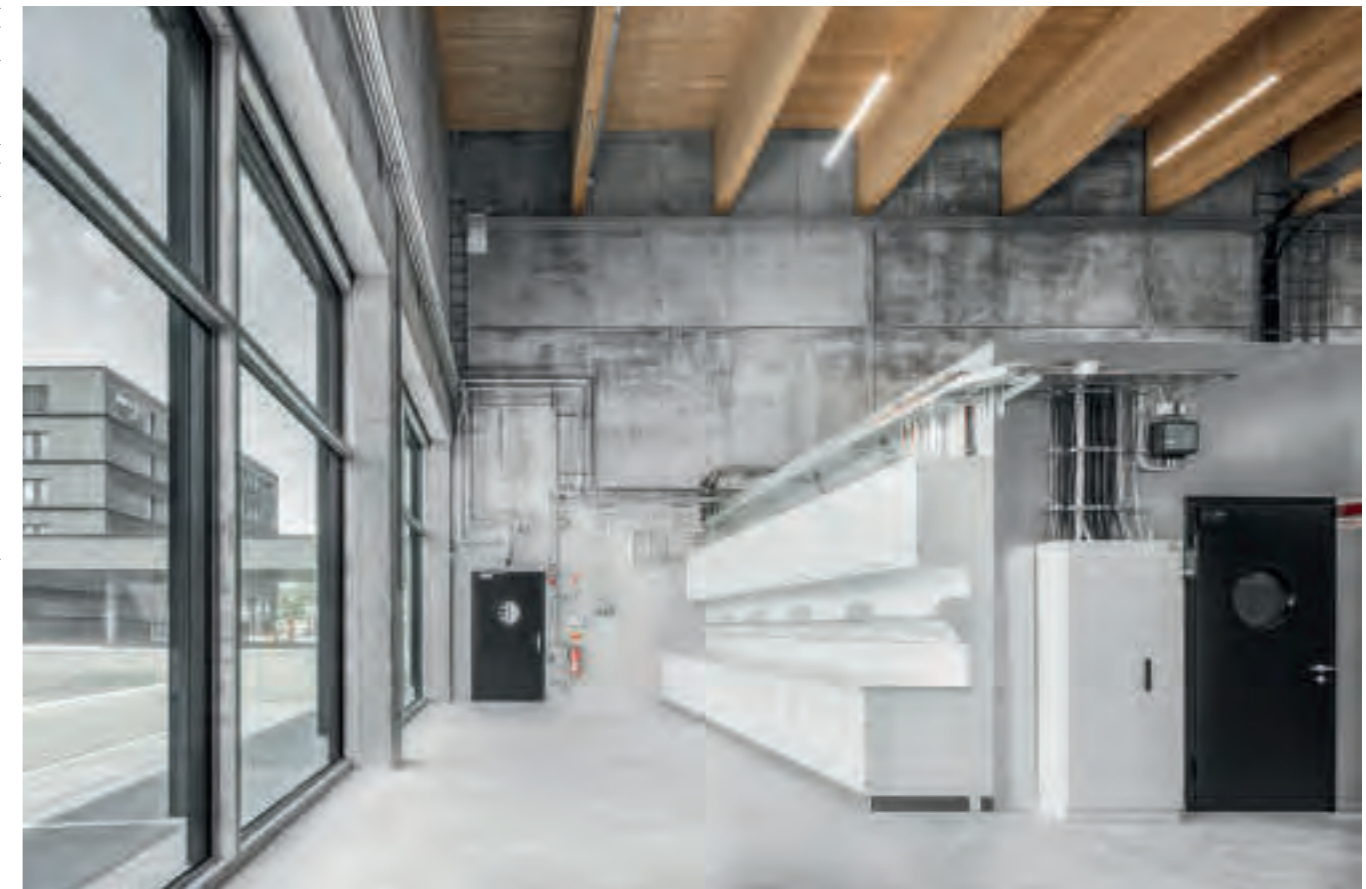
Die Brandwände der Hallen im Technikum sind aus unbehandeltem Sichtbeton.
