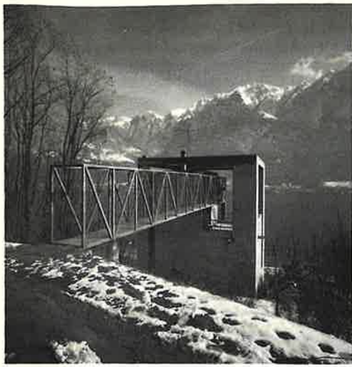
Haus in Riva San Vitale am Luganer See, Architekt: Mario Botta
