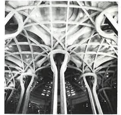
Blick von der Seite in den Zentralraum; sichtbar die von den Pfeilern ausgehende Verknüpfung der Dachkonstruktion
