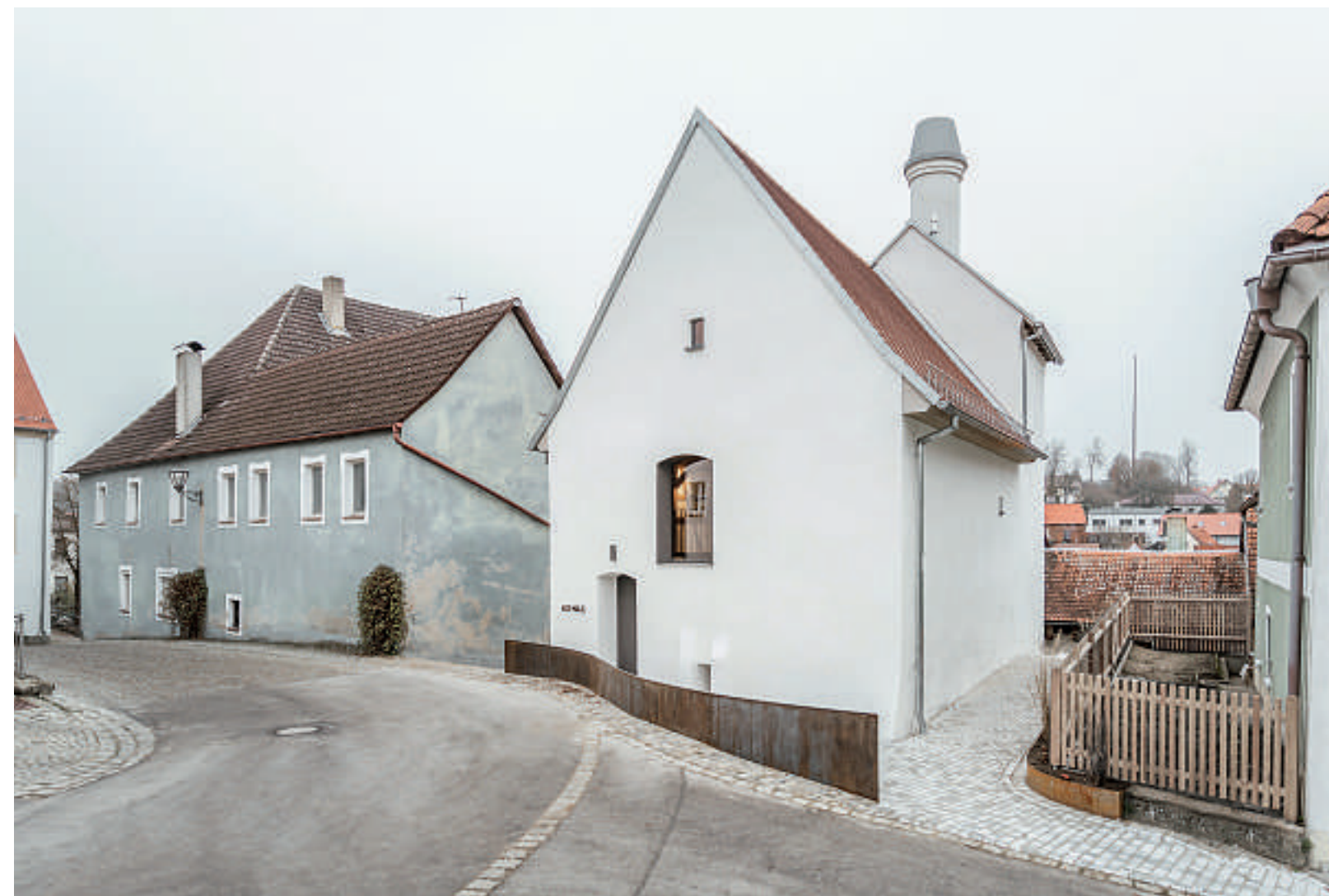
Jetzt dient das Haus als Kulturtreff. Die Denkmalpflege erlaubte eine einheitliche Fassadengestaltung. Cortenstahl sorgt für Schutz an der scharfen Kurve.
