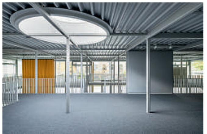
**Achtzig Prozent der Energieversorgung stammen aus Fernwärme in Kombination mit Erdsonden, die das Gebäude im Sommer kühlen sollen. Die Stahlstützen entwässern das Dach, indem sie das Regenwasser intern in den Boden leiten.**
