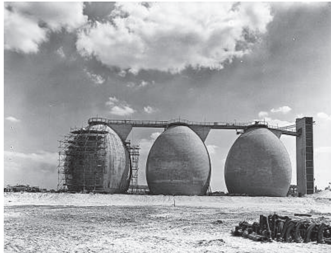
Klärwerk Köhlbrandhaff, Faulturmbehälter im Bau, 1958. Foto: Hamburgisches Architekturarchiv
