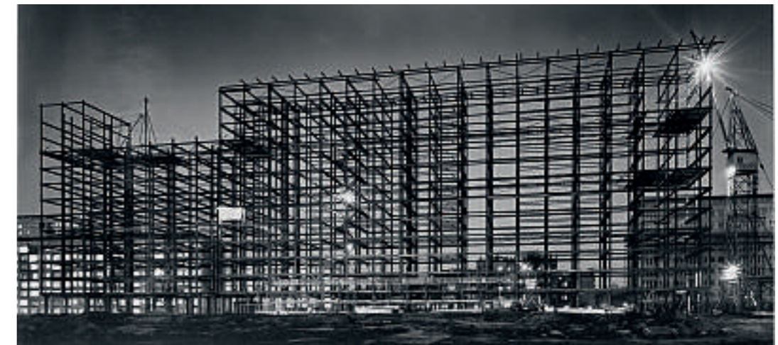
Stahlskelett des Grindelhochhauses 2 bei Nacht, 1952. Foto: Hamburgisches Architekturarchiv
