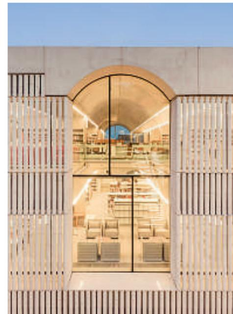
Die 15 Zentimeter dicken Säulchen vermitteln zwischen innen und außen: Sie schützen vor direkter Sonneneinstrahlung und geben trotzdem einen Eindruck von Durchlässigkeit. Längs- und Querschnitt im Maßstab 1:500
