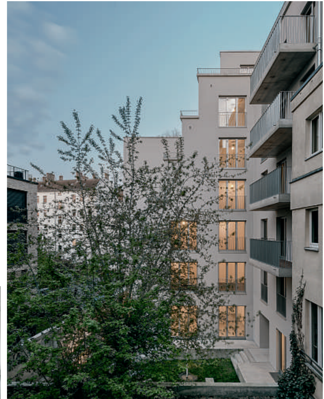
Der hintere Gebäudeteil ist abgestuft; hier im zweiten Hof wurde ein Garten angelegt. Schnitt im Maßstab 1:500
