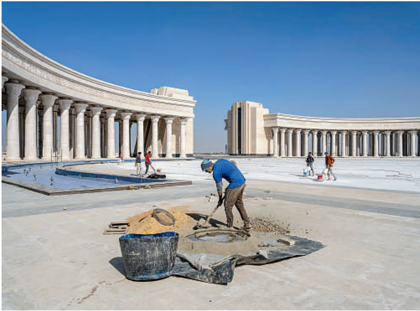
Arbeiter füllen die Fugen zwischen den Fliesen am neu errichteten Arc de Triomphe in Ägyptens neuer Verwaltungshauptstadt. Unten: Imbissstand in der Nähe der neu erbauten Kathedrale „Cathedral of the Nativity of Christ“.
