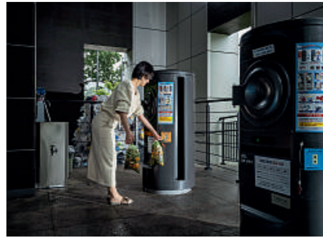
Eine Bewohnerin wirft in einen Abfalleinlass ihren Müll weg. Der Behälter öffnet sich elektronisch, der Müllsack fällt in ein unterirdisches Rohrsystem. Links: Im Ausgehviertel Naseong-ro
