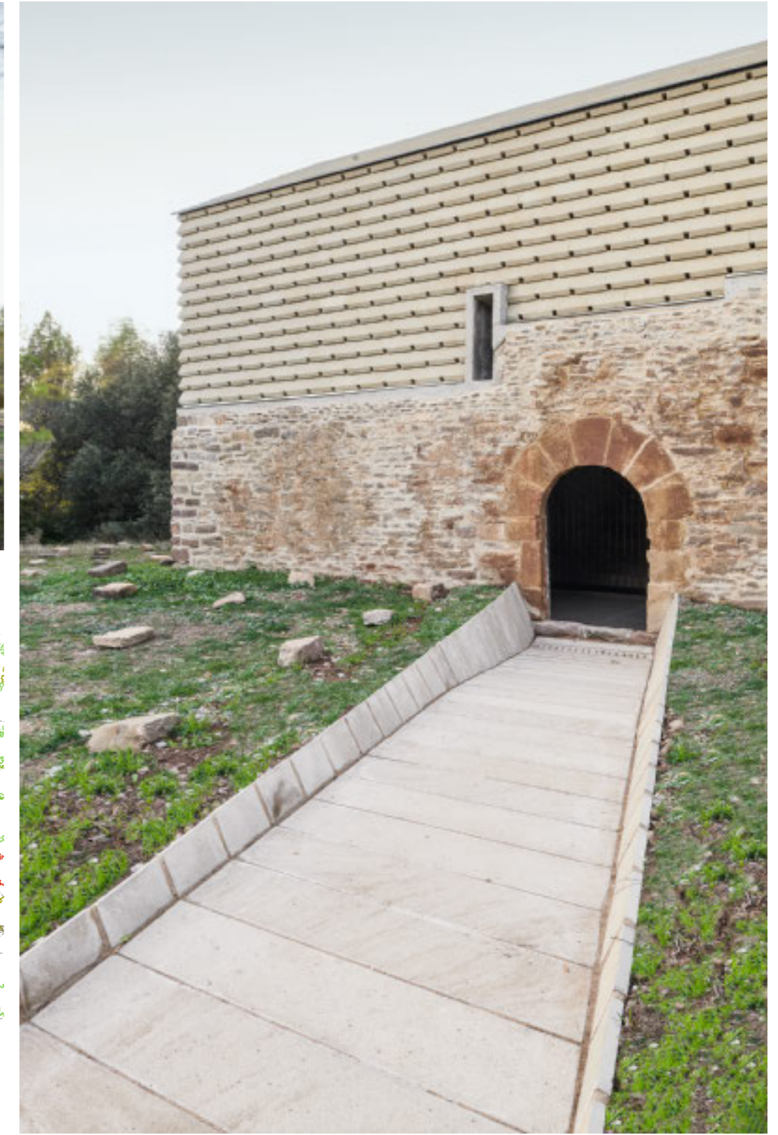
Die Regelmäßigkeit der neuen Fassade kontrastiert zur handwerklichen Ausführung des Sockels und macht den Unterschied zwischen neu und alt unmissverständlich sichtbar. Lageplan im Maßstab 1:500
