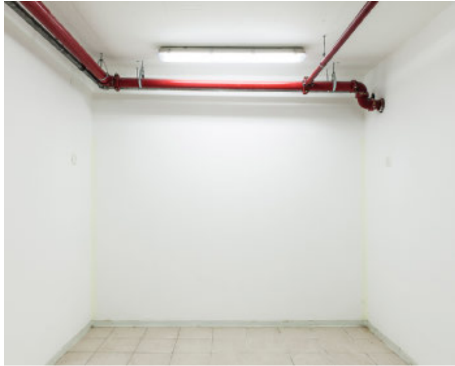
Oben: Bomben-Schutzraum für die Angestellten des Tel Hai-Industrieparks Unten: Kommandozentrale/ Bombenschutzraum für die Golan-Region, Ein Zivan, an der Grenze zu Syrien
