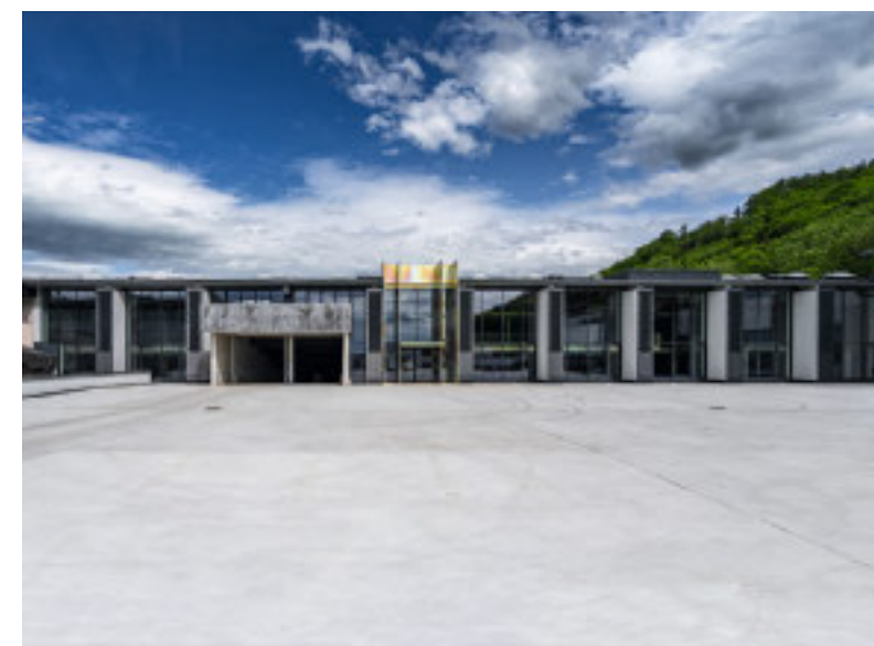
Die ehemals allseitig eingebaute Halle 2 im Osten des Komplexes hat eine Fassade gewonnen, indem die angrenzende Halle in der Höhe um ein Geschoss gekürzt wurde und nun als Parkdeck dient.
