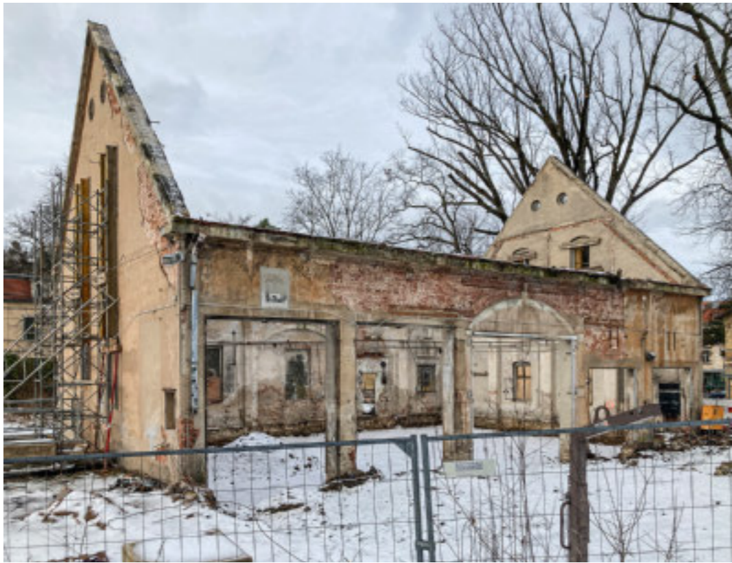
Dach und Innenwände waren beim Besuch im Januar bereits abgetragen. Die Zeugnisse der NS-Umbaumaßnahmen werden nach Abschluss der Umbauarbeiten nicht mehr deutlich erkennbar sein.
