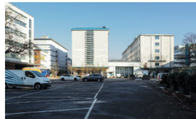
Zwischen den drei Tabak-Lagern waren in den Achtzigern auf ganzer Höhe Lagerbauten eingezogen worden. Jetzt stehen sie wieder frei. Die „Grande Garage“ ist als offene Werkstatt Herzstück der Tabakfabrik. Unten: Zugang zur ROSE vom Peter-Behrens-Platz, dahinter das ArtMagazin Fotos: jl
