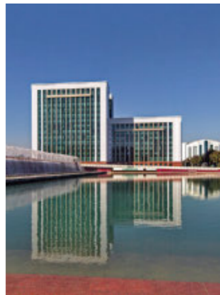
Das Haus der Ministerien im Jahr 2000, während des Umbaus 2005 und 2008: Die oberen Geschosse abgebrochen und „karimowisiert“. Fotos: Philipp Meuser
