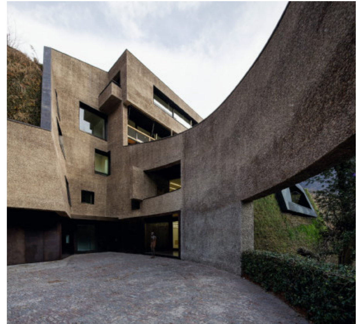
Material-Recycling an Ort und Stelle: Das Aushubmaterial wurde dem Sichtbeton als Zuschlag beige-mengt.
