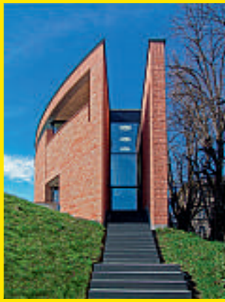
2006 bezog die Bibliothek ein eigenes Gebäude, das nach Plänen von Mario Botta im Garten des Oechslinschen Wohnhauses entstand (Bauwelt 23.2006). Fotos: Robert Rosenberg, Einsiedeln © Stiftung Bibliothek Werner Oechslin
