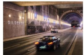
ner Beleuchtung versehen. Den letzten und längsten Abschnitt bildet ist ein hundert Meter langer Rundbogentunnel mit 11,5 Metern Scheitelhöhe. Engstrahlende Würfelleuchten zeichnen das dunkle Gewölbe mit acht feinen blauen Lichtbögen nach und intensivieren die Intervention mit der dritten Dimension, bis sie an der Ausfahrt abrupt endet.
