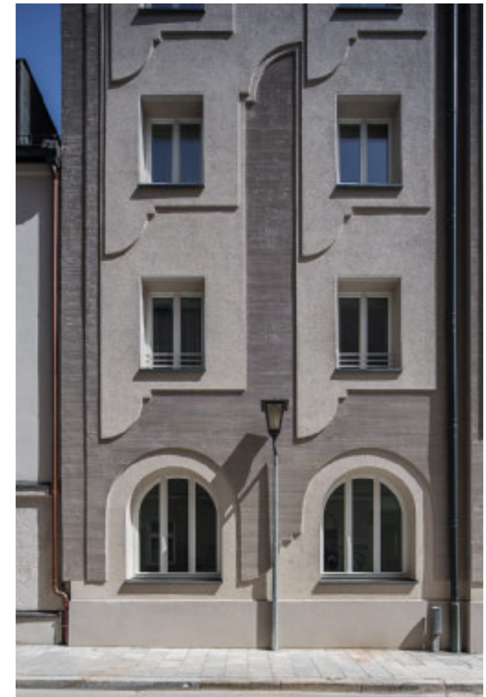
Nicht jede öffentliche Vergabe endet mit Schrecken: Sanierte Fassade des Abgeordnetenhauses Ismaninger Straße (Hild und K, 2013). Foto: Michael Heinrich
