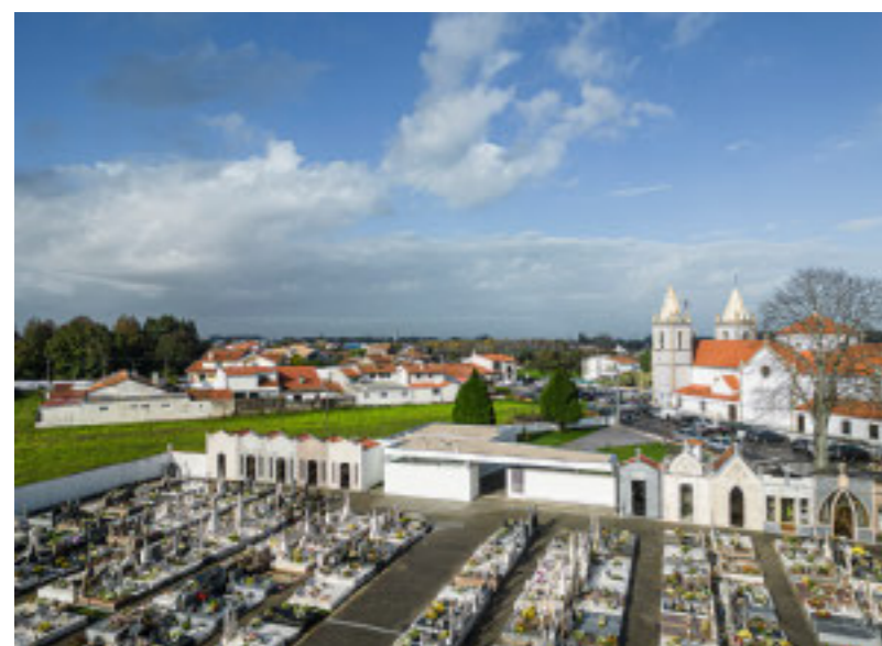
Gegenüber der Kirche Santo António von Oliveirinha liegt der nördlichere der beiden Friedhöfe der Stadt. Die neue Trauerhalle erweitert das Angebot vor Ort und akzentuiert am Friedhof den Eingang.
