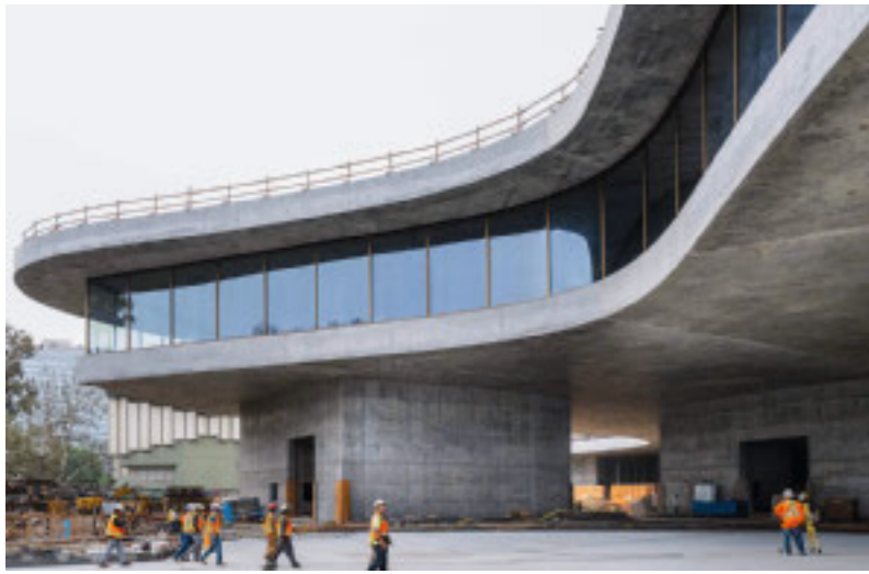
Am 25. Oktober fielen nach vier Jahren Bauzeit die letzten Gerüste an Peter Zumthors Erweiterungsbau des LACMA. Die „David Geffen Galleries“ sollen im April 2026 eröffnet werden. Foto: Museum Associates/LACMA by Gary Leonard
