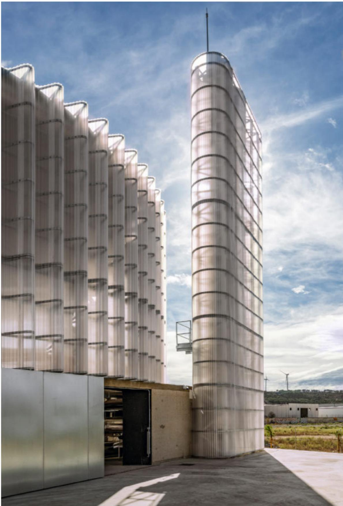
Über dem schweren Betonsockel erhebt sich eine leichte „Laterne“, eine Stahlkonstruktion mit transluzenter Verkleidung. Die ovale Grundrissform verstehen die Architekten als Symbol des technischen Kreislaufs im Kraftwerk. Über die Luken auf dem Vorplatz wird die Biomasse ins unterirdische Silo eingebracht. Lageplan im Maßstab 1:15.000
