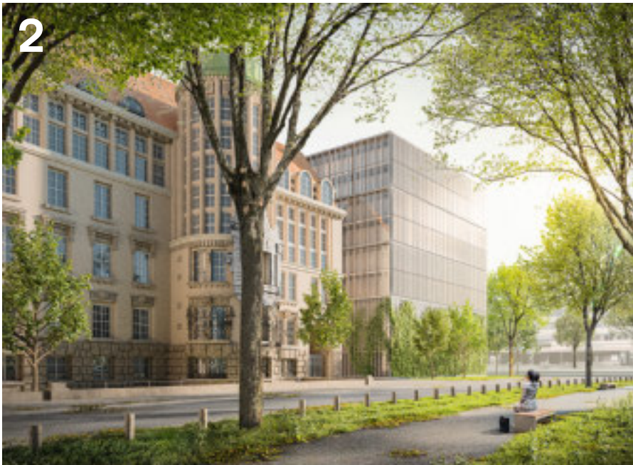
2. Preis AV1 Architekten haben ihr Archiv entlang der Curiestraße ebenfalls gestaffelt, jedoch mit einer Solarfassade umhüllt, die die Geschossigkeit andeutet. Abbildungen: AV1, Grundriss EG im Maßstab 1:750
