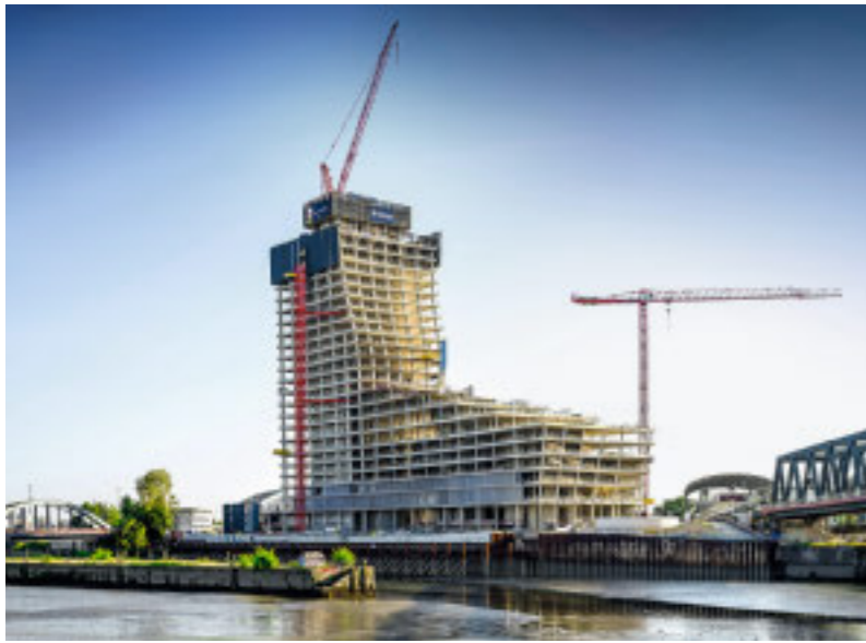
Der Sockelbau des Elbtowers steht bereits. Zur Vollendung auf 48 Obergeschosse fehlen noch knapp 150 Höhenmeter. Fotos: Bildagentur-online/Ohde/Alamy Stock Photo
