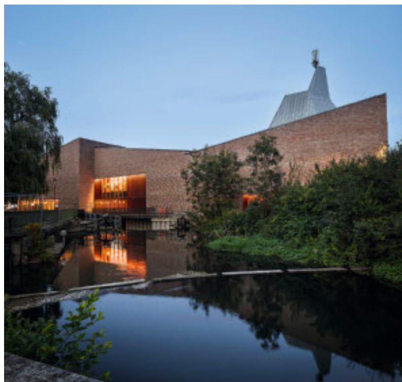
Im großen Saal gewannen die Architekten Raum für einen Rang, indem sie die Abhangdecke demontierten und das Auditorium weniger steil anordneten. Erdgeschoss, Obergeschoß und Schnitt im Maßstab 1:500
