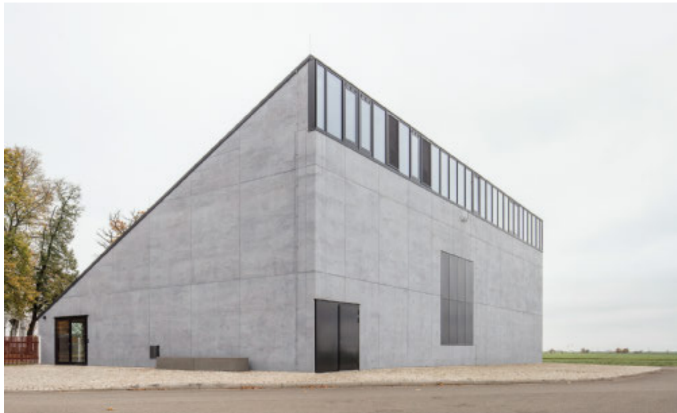
Die einfache, von landwirtschaftlichen Zweckbauten abgeleitete Geometrie wird mit feinen Details als Kulturbau kenntlich gemacht. Durch die große, bündige Öffnung in der Nordostfassade ermöglicht das Ein- und Ausbringen des Hauptexponats.
