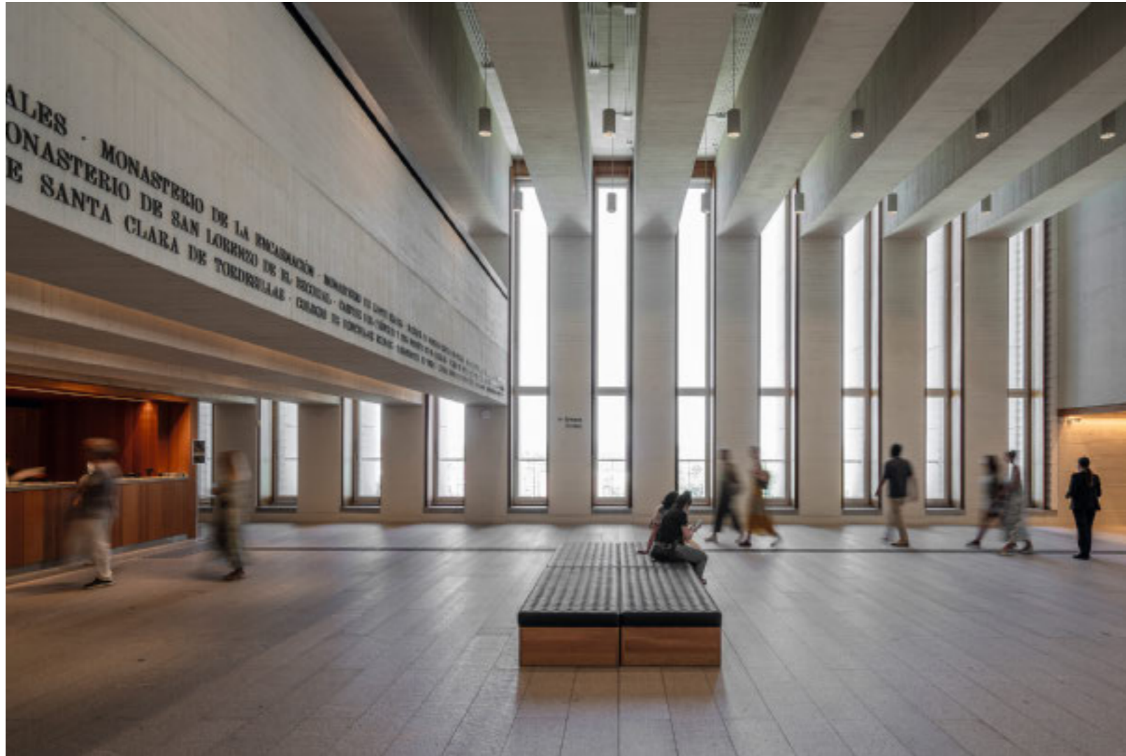
Deckenbalken und Fassadenpfeiler sind gleich dimensioniert. Blick ins Foyer. Schnitt im Maßstab 1:1500
