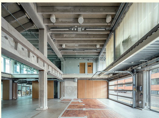
Die Erweiterung des Gebäudes um 1,5 Meter diente sowohl den vertikalen Installationen als auch statischen Anforderungen. Die Fassadenbacksteine wurden als Bodenbelag wiederverwendet. Links: Das Foyer mit Cafébereich vor der Einrichtung.
