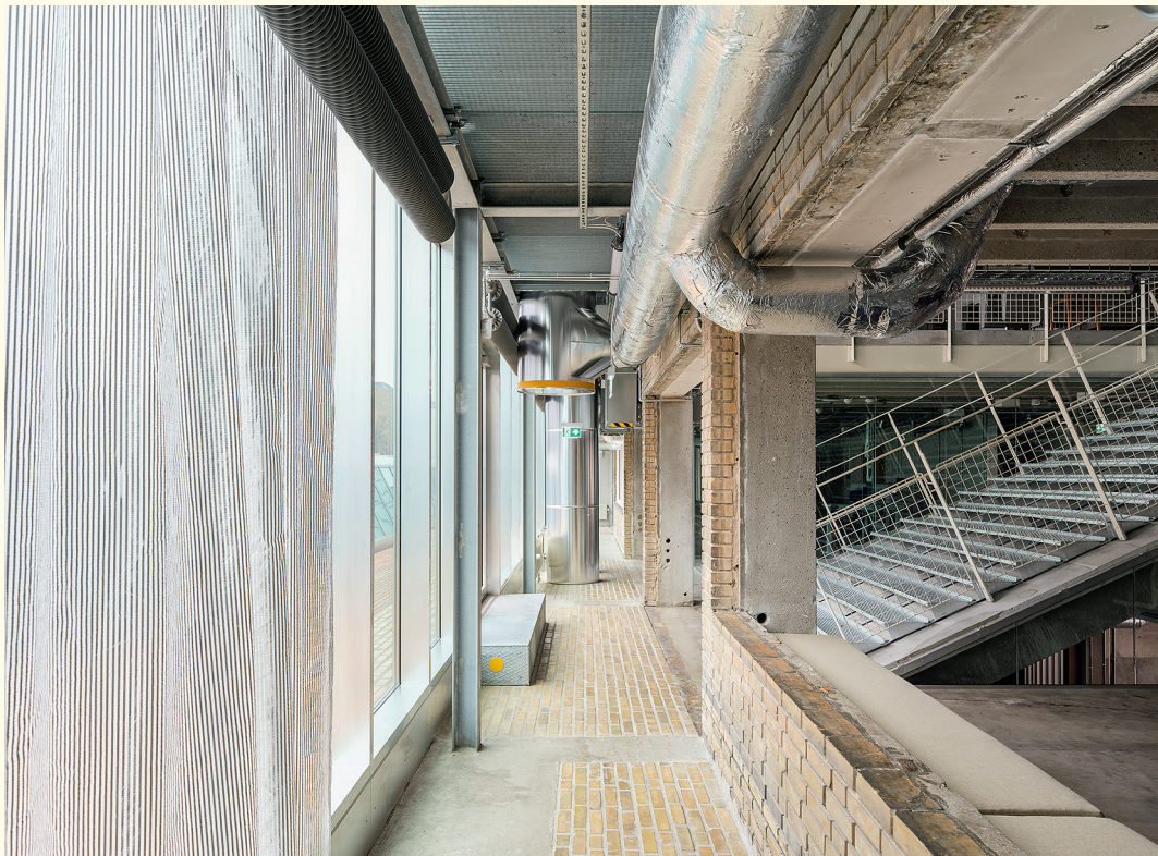
Die Erweiterung des Gebäudes um 1,5 Meter diente sowohl den vertikalen Installationen als auch statischen Anforderungen. Die Fassadenbacksteine wurden als Bodenbelag wiederverwendet. Links: Das Foyer mit Cafébereich vor der Einrichtung.
