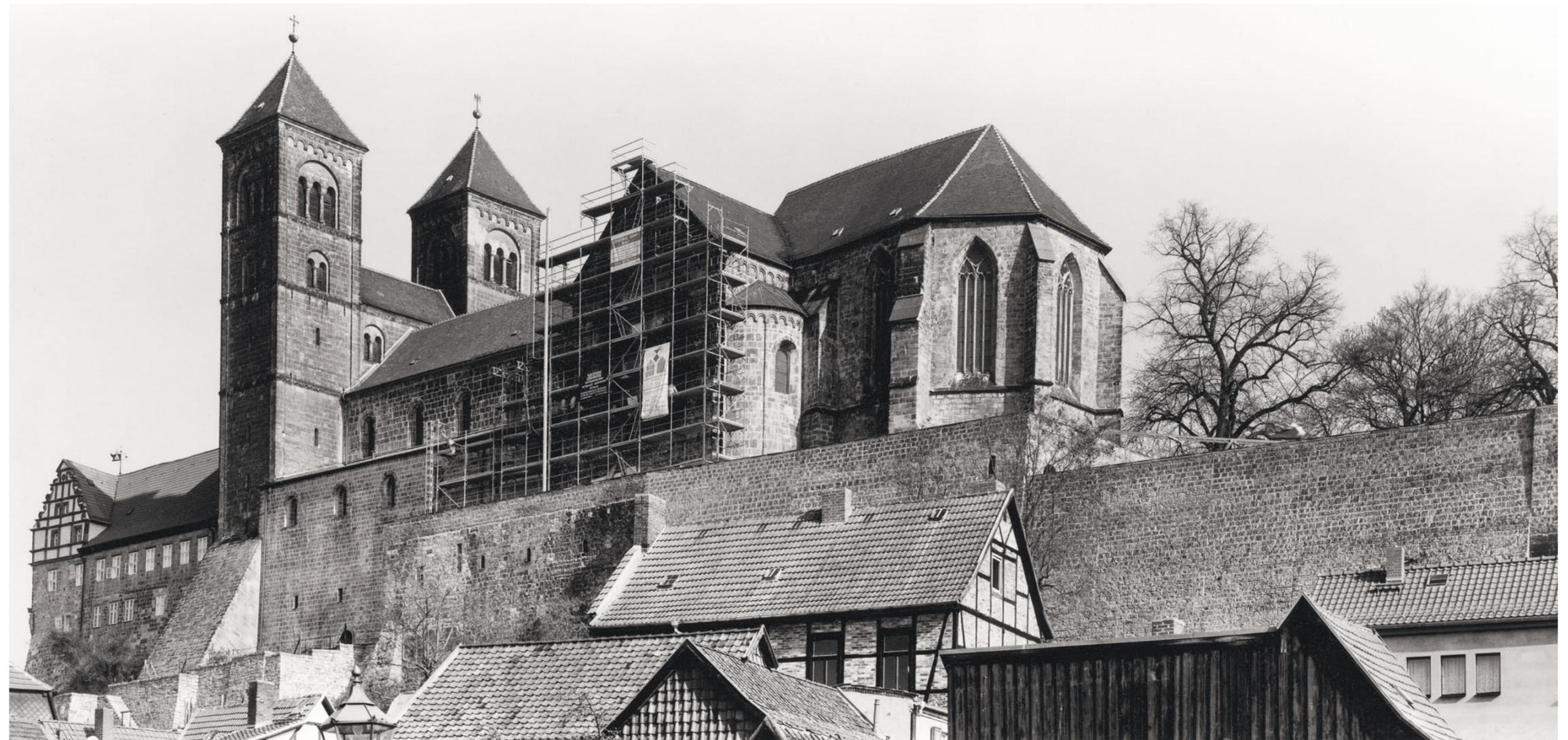
Nicht zum ersten Mal bereitet die Statik des Sandsteinmassivs des Schlossbergs Probleme: 1571 musste bei der Stiftskirche St. Servatius die Südwand des Querschiffes teilweise neu aufgerichtet werden, 1708 dann die Südwand des Langhauses.
