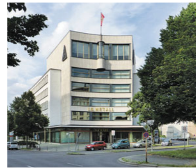
Das IG-Metall-Haus zwischen Alter Jakobstraße und Lindenstraße in der südlichen Berliner Friedrichstadt entstand 1929 nach Plänen von Erich Mendelsohn und Rudolf W. Reichel. Foto: Stephan Pinkau
