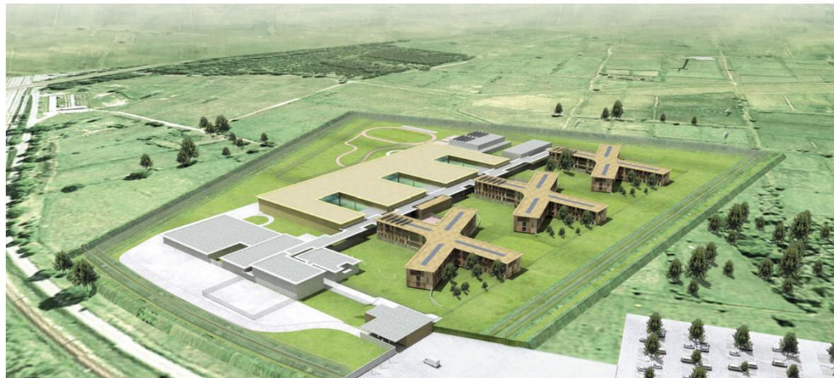
Der Aufbau einer Justizvollzugsanstalt folgt strengen Normen. So trennt bei allen Entwürfen eine etwa 300 Meter lange Magistrale die Zellentrakte von den Werkstätten sowie Service- und Freizeiteinrichtungen. Das Grazer Büro Hohensinn (1. Preis) will diese Magistrale im Sinne humanerer Haftbedingungen vom Boden bis zur Decke verglasen (Bild links oben).
