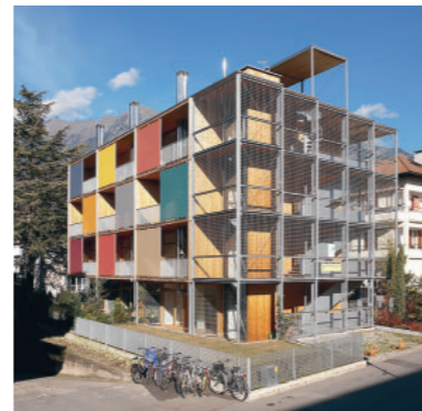
Obere Reihe links: Belastete Idylle – Gerd Bergmeisters Wohnhaus in Franzensfeste liegt direkt an der Brennerautobahn; Frischluft wird über ein Lüftungssystem aus dem Wald angesaugt. Daneben: Der Deutsch wie Italienisch gleich lautende Ortsname von Plaus trägt das Vordach der neuen Haltestelle der Vinschgau-Bahn (Architekturbüro D3).
