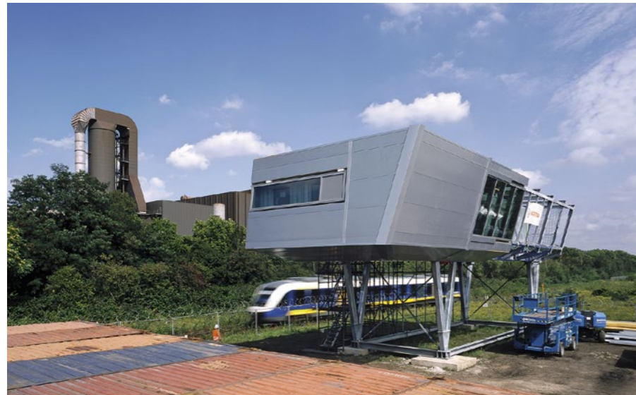
Die aufgestellte Station wurde in Duisburg zunächst als Mock-up in Teilen errichtet. Die Container wurden nahezu komplett ausgestaltet verschifft.
