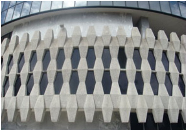
Das American Federal Building in Orlando entstand 1963 nach Plänen von Bob Murphy. Seine Fassade besteht aus 120 vorgehängten Betonelementen. Später wurde ein verglastes Bauteil aufgesetzt.
