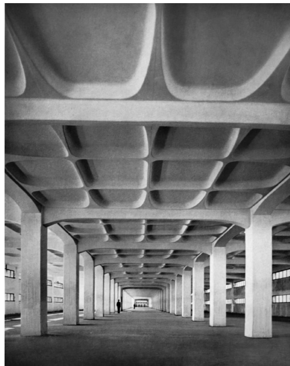
Historisches Foto der besonderen Kassettendecken-Konstruktion aus Ferrozement
